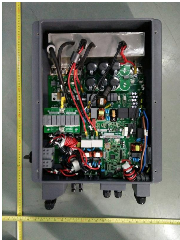
Figura 4, Visão interna Figure 4, Internal view
